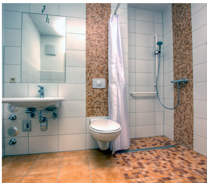
Ein fertig modernisiertes Bad mit ebenerdiger Dusche.
